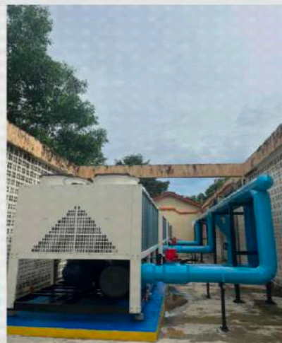
Kerja-kerja penggantian chiller di Bangunan ITITC
